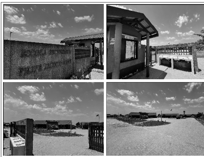
Fotografia 4.1 Vista frontal e interior da escola
