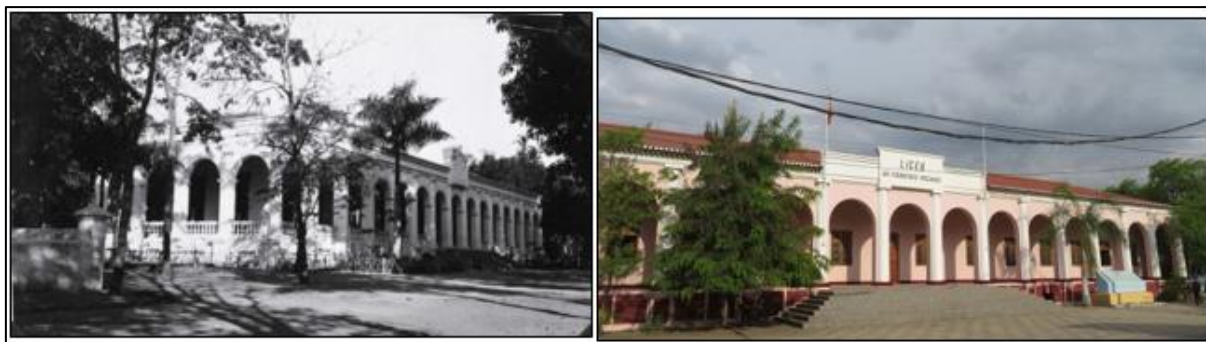
FIGURA 5: EDIFÍCIO DO LICEU DR. FRANCISCO MACHADO/FEAH-DÍLI
