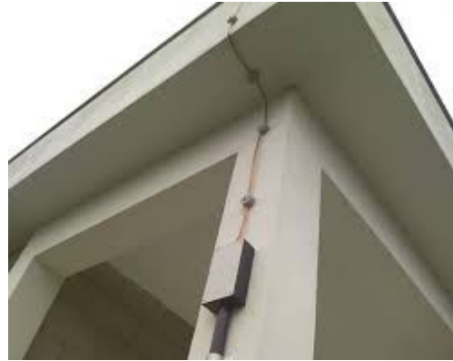
Fig.13- Descida de aterramento com fixação na estrutura
