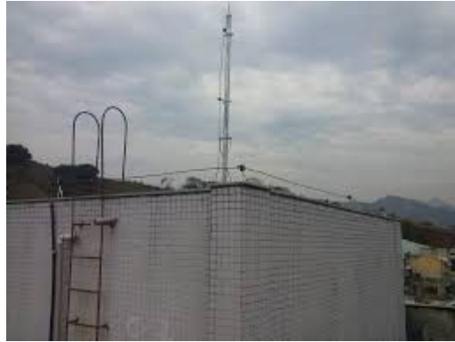
Fig.07- Sistema de SPDA com captor
