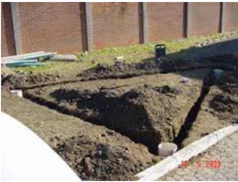
Fig.14 -Malha de terra em triangulo
