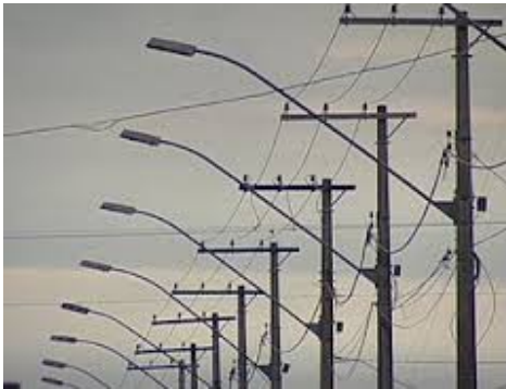
Fig.41- Estrutura de distribuição 13.8kV fig.42 – Estrutura de distribuição 69kV
