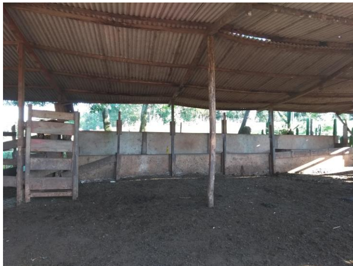
Figura 4 – Instalações para manejo do gado Ibiporã - PR, 2019.
