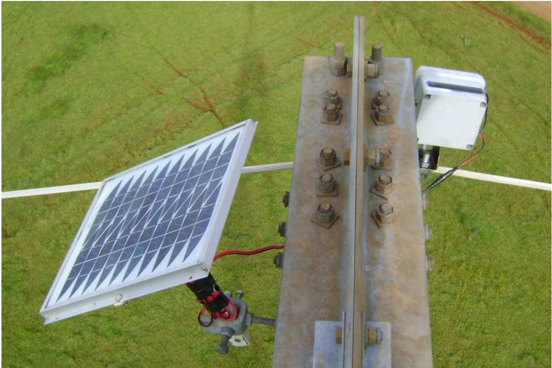
Figura 4.6 – Montagem do painel solar. Foto: o autor.
