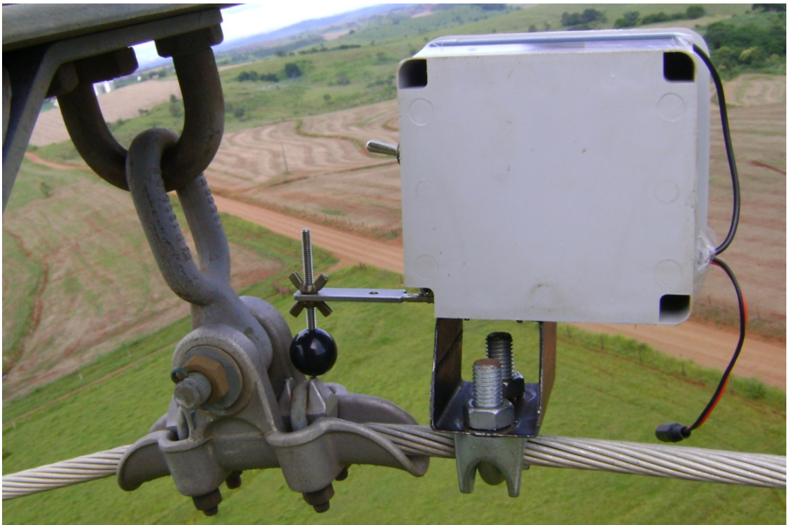
Figura 4.5 – Montagem do vibrógrafo. Foto: o autor.
