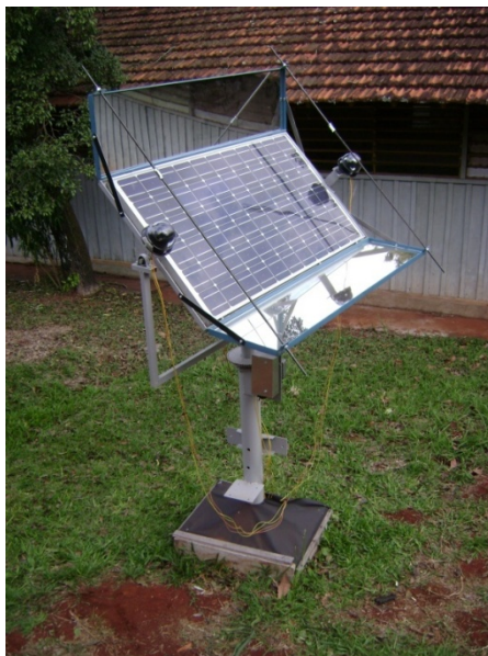
Figura 4.4: Estrutura para posicionamento do painel solar com espelhos concentradores.
