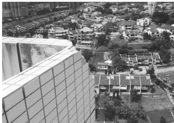
Figura 3.8: Beiral atingido por descarga atmosférica. Fonte: (Hartono 2000)
