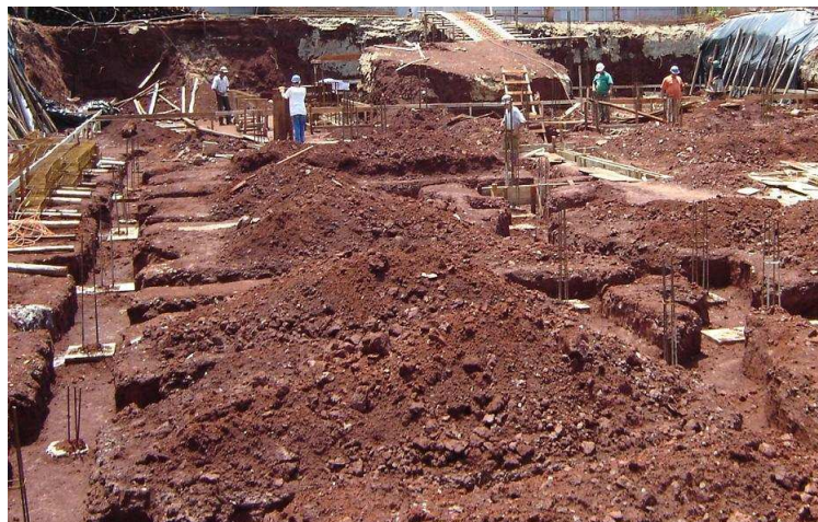
Figura 2.4: Escavações para baldrames.
