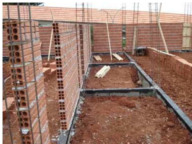
Figura 2.7: Baldrames como apoio para as paredes.
