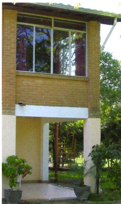
Figura 3.11: Edificação rural atingida por descarga. Fonte: (ALVES, 2006)
