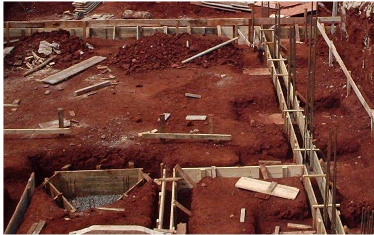
Figura 2.5: Fôrmas para baldrames.
