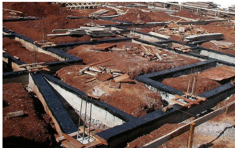
Figura 2.6: Baldrames concretados e com camada de impermeabilização.
