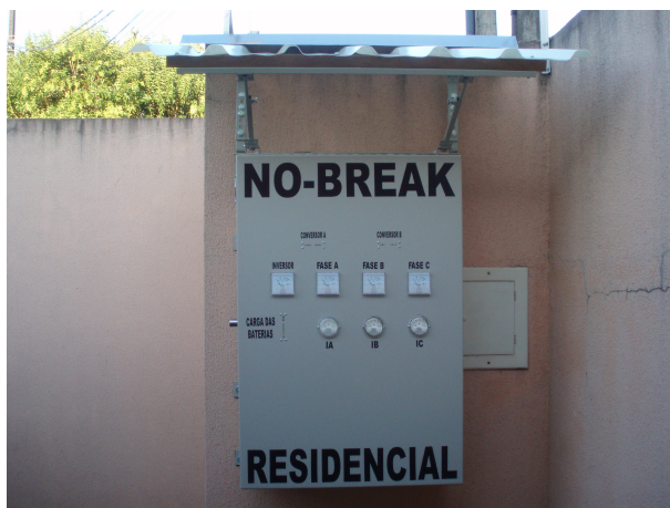
Figura 4.18 – Circuito do UPS instalado em uma residência
