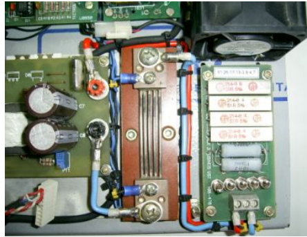
Figura 110 – Foto banco de carga com cooler e resistor shunt .
