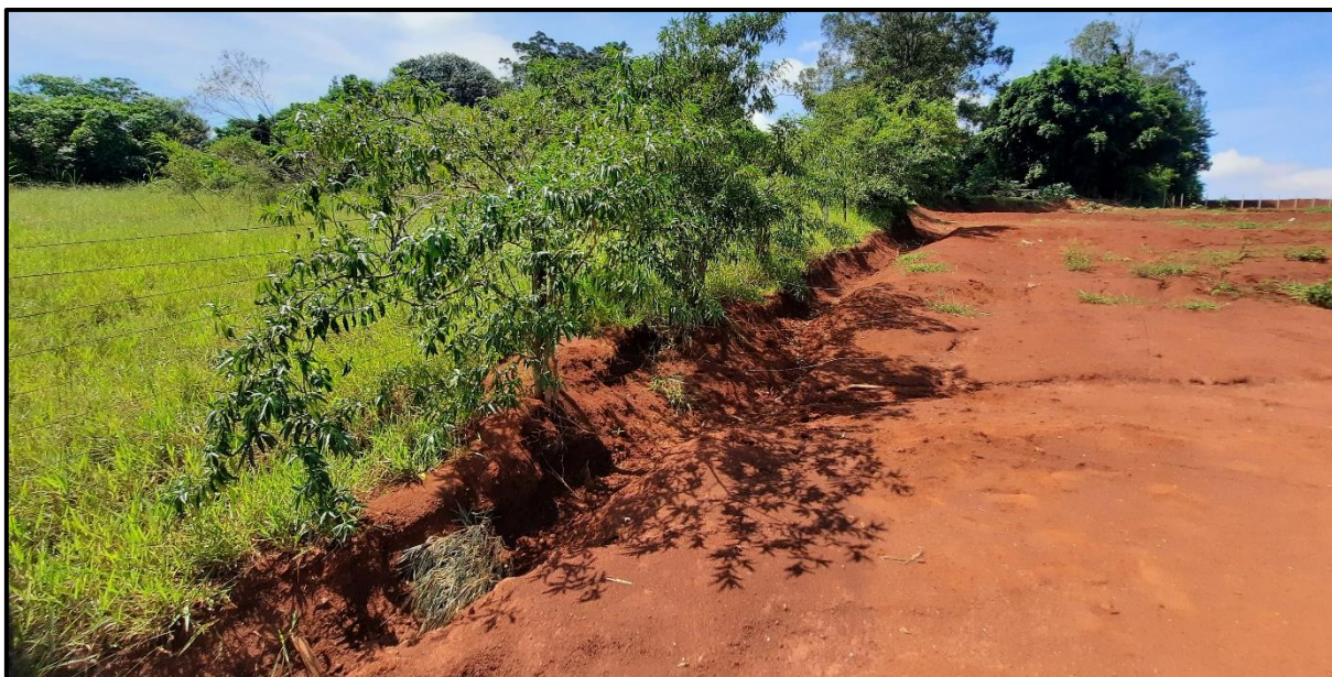
Figura 24 – Ravina em estágio avançado próximo ao tanque de contenção de água da VIAPAR.
