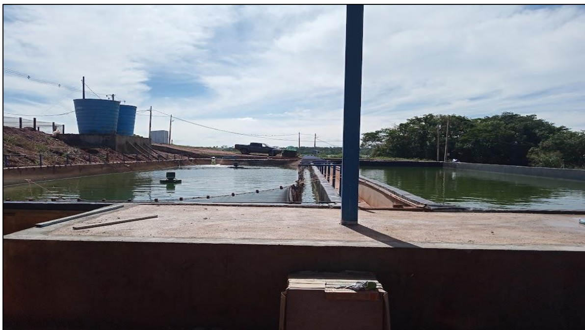
Figura 45: Tanques de alvenaria do sistema de conexão entre tanques escavados e tanques-rede, Global Peixes e Alevinos, Rubinéia-SP.
