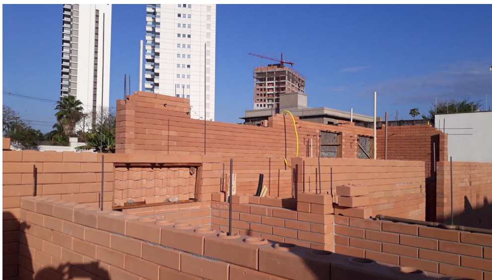
Figura 27 – Execução de obra com tijolos ecológicos
