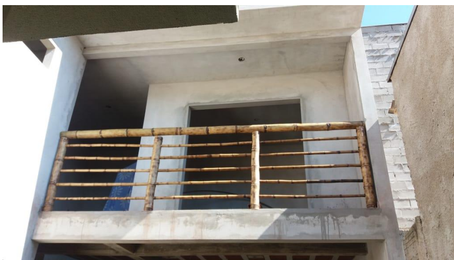
Figura 01 – Processo de execução do guarda-corpo em bambu
