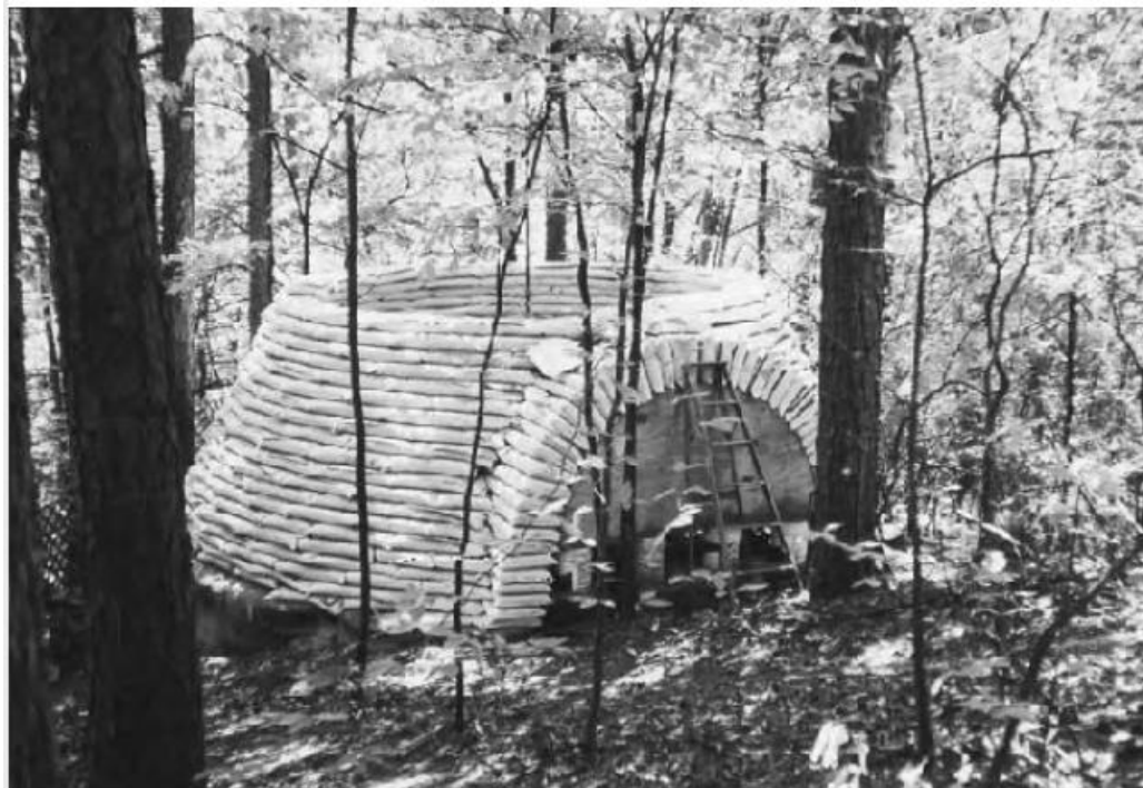
Figura 16 – Construção com superadobe (earthbags) – Georgia (EUA)
