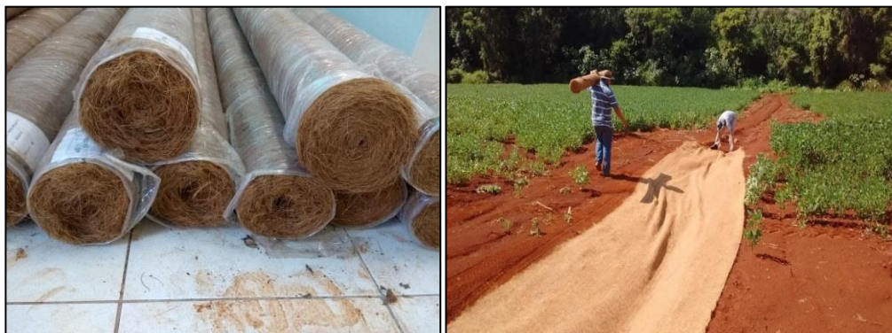
Figura 78. Rolos de fibra de coco (à esquerda) e instalação da manta no canal escoadouro (à direita).
