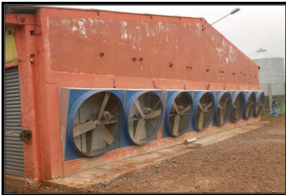
Foto 11: Aviário com sistema de exaustores. Com capacidade de alojamento de 24 a 28 mil frangos, com tamanho de 13X136m.
