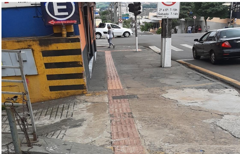
Figura 11 - Pisos táteis inseridos de forma errada na rua João Cândido, área central de Londrina (PR)
