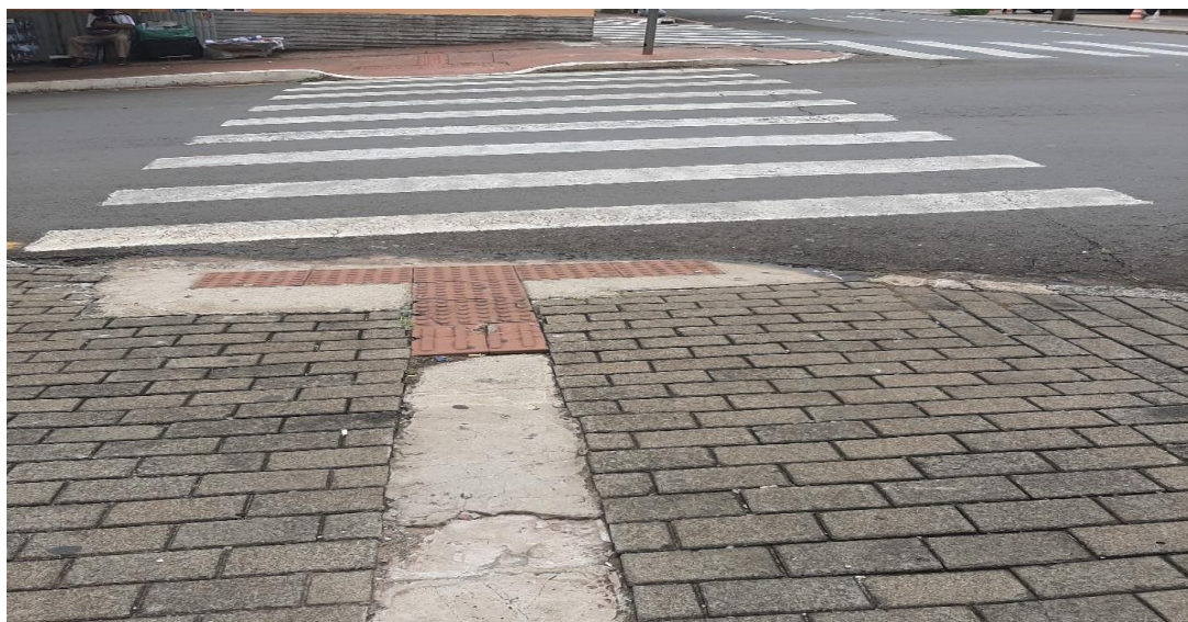
Figura 8 - Piso tátil em péssimas condições, entre a rua João Cândido e Benjamin Constant nas proximidades do terminal central na área central da cidade de Londrina (PR)
