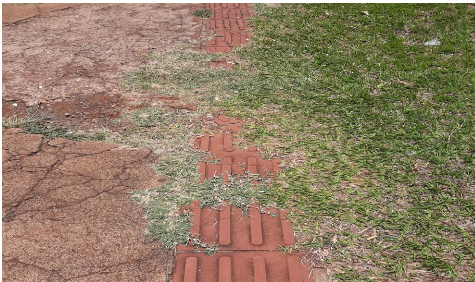
Figura 9 - Piso tátil em péssimas condições, coberto em partes por grama na rua Potiguares
