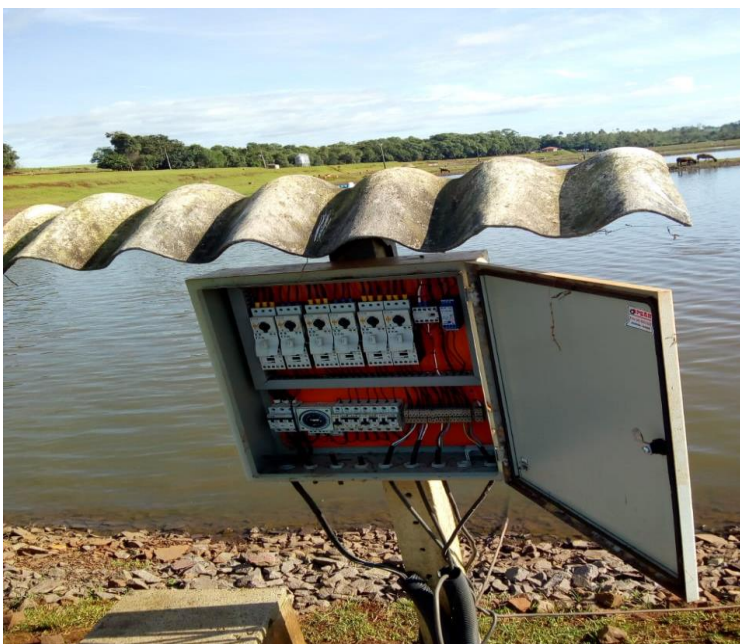
Figura 19: Central de controle dos aeradores
